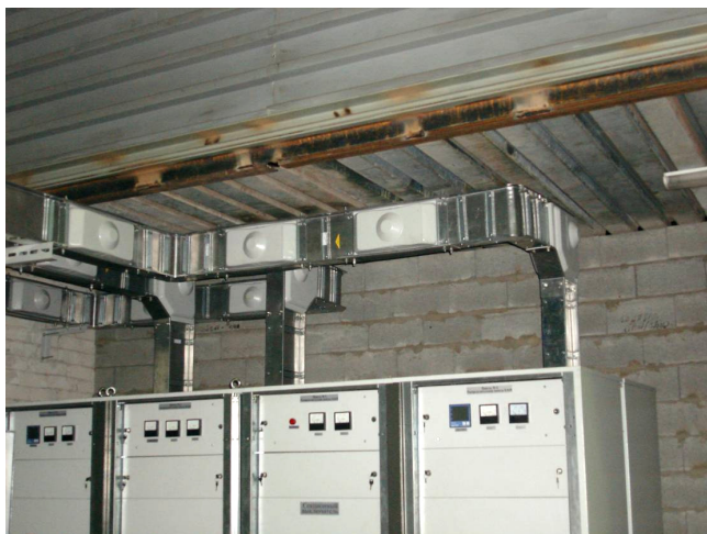
Рис.1 Применение комплекта крышек угловых У5137Р для разъёмного соединения шин секций шинпровода на РП18А ОАО «СОЭМИ».
